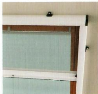
3 – Pose à l'extérieur de face par fixations pvc
