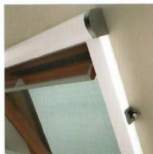
4 – Pose fenêtre de toit de face par fixations pvc
